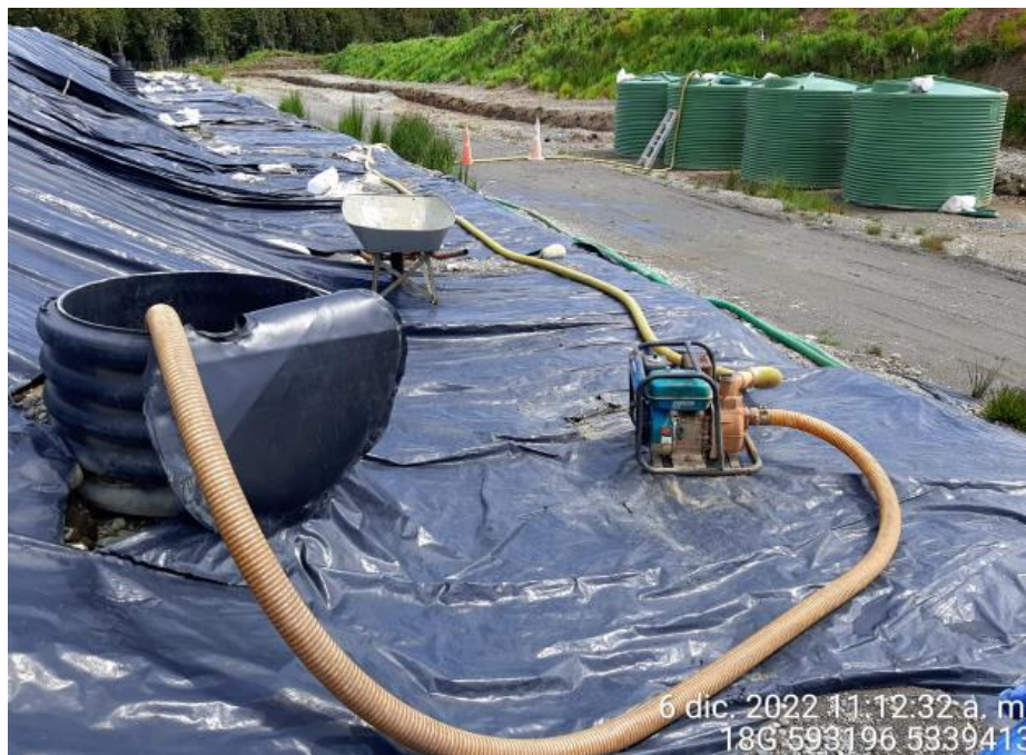
Fotografía N°4: Extracción de Lixiviados desde cámara C13 por personal municipal. Tomada: Martes 06 de Diciembre del 2022.
