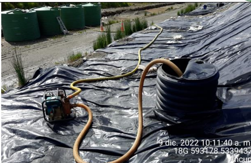
Fotografía N°14: Extracción de Lixiviados desde cámara C12 por personal municipal. Tomada: Viernes 09 de Diciembre del 2022.
