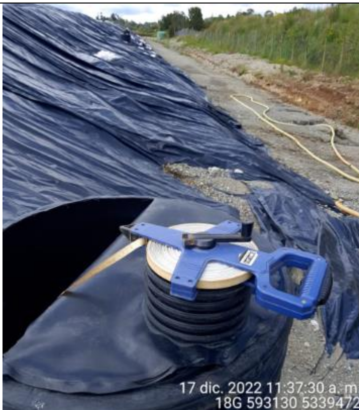
Fotografía N°56: Medición de Niveles de cámaras por Personal Municipal. Tomada: 17 de Diciembre del 2022.
