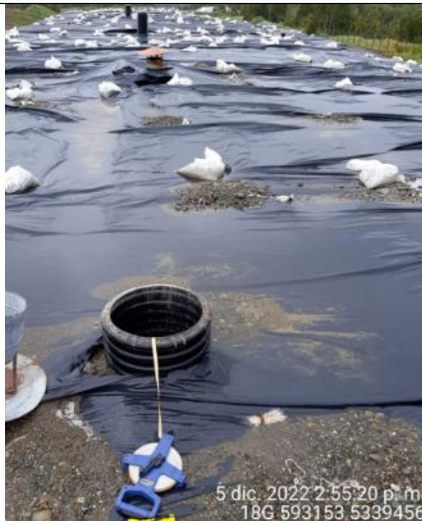
Fotografía N°47: Medición de Niveles de cámaras por Personal Municipal. Tomada: 05 de Diciembre del 2022.
