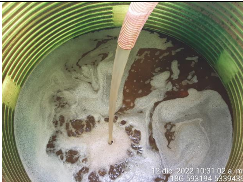
Fotografía N°19: Extracción de Lixiviados a estanque. Tomada: Lunes 12 de Diciembre del 2022.
