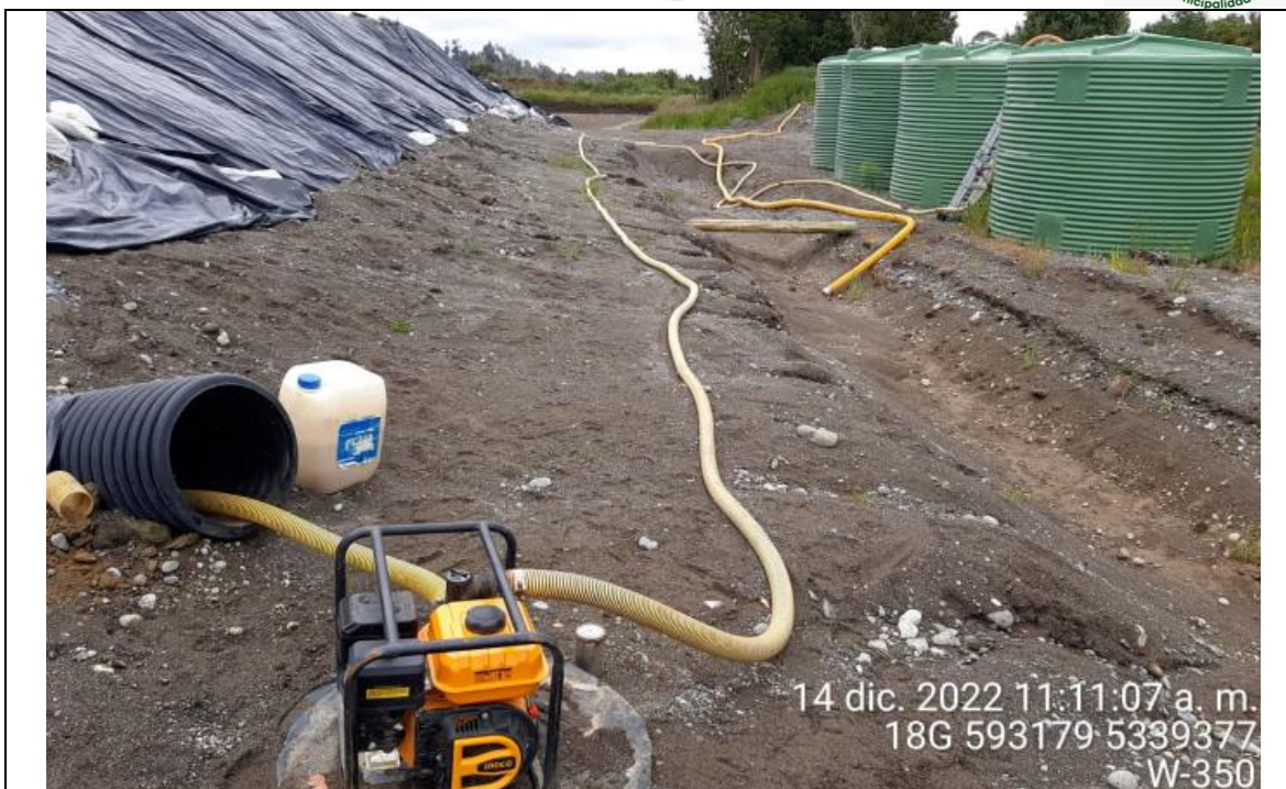
Fotografía N°31: Extracción de Lixiviados desde diagonal D02 por personal municipal. Tomada: Miércoles 14 de Diciembre del 2022.
