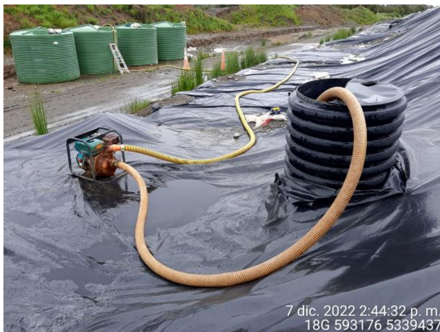
Fotografía N°7: Extracción de Lixiviados desde cámara C12 por personal municipal. Tomada: Miércoles 07 de Diciembre del 2022.
