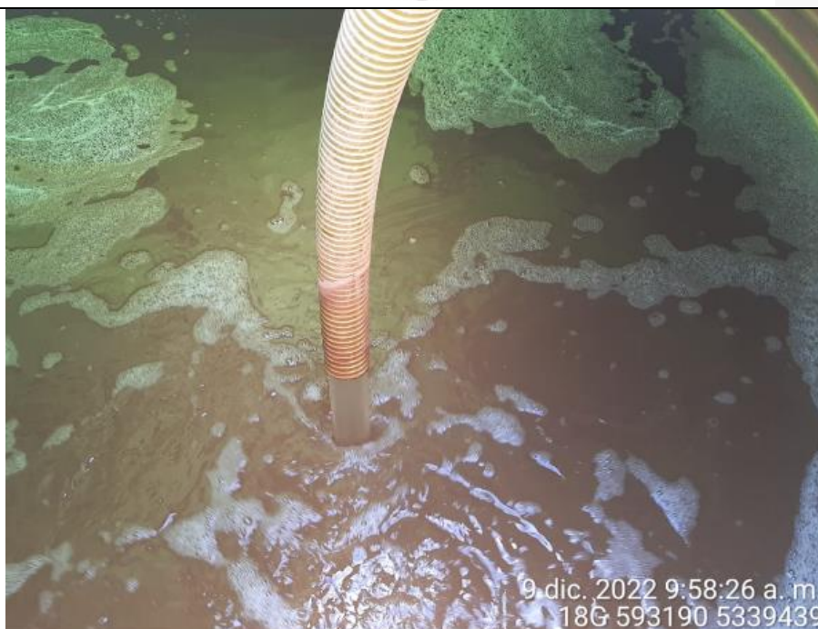
Fotografía N°16: Extracción de Lixiviados a estanque. Tomada: Viernes 09 de Diciembre del 2022.
