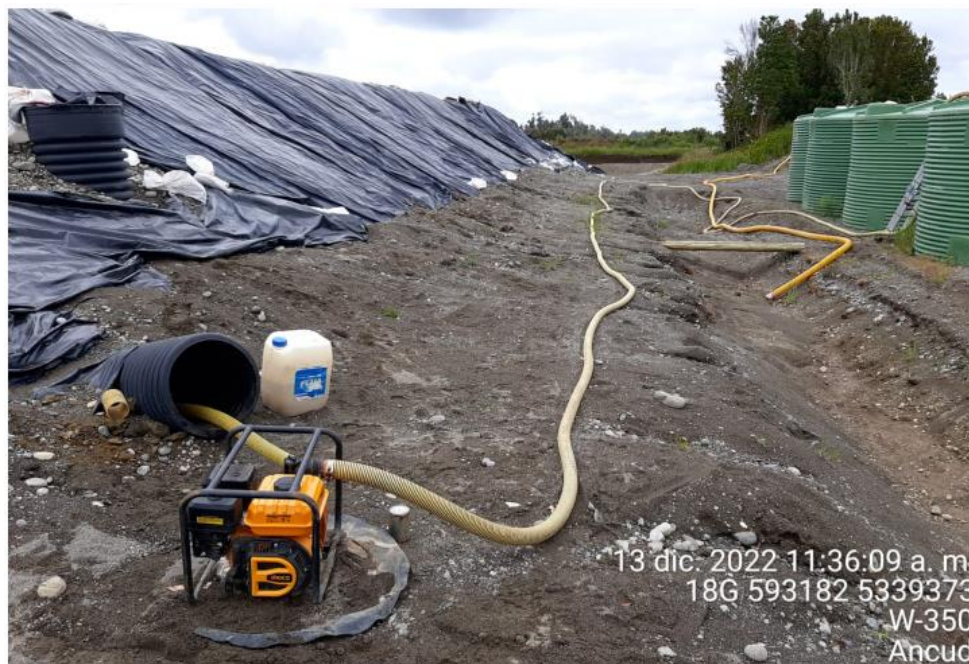
Fotografía N°25: Extracción de Lixiviados desde diagonal D02 por personal municipal. Tomada: Martes 13 de Diciembre del 2022.
