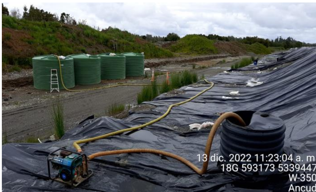
Fotografía N°27: Extracción de Lixiviados desde cámara C12 por personal municipal. Tomada: Martes 13 de Diciembre del 2022.
