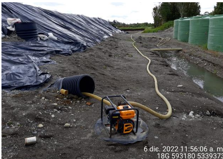
Fotografía N°5: Extracción de Lixiviados desde ducto diagonal D02. Tomada: Martes 06 de Diciembre del 2022.
