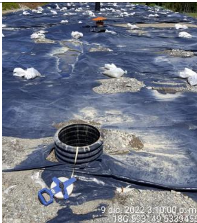
Fotografía N°50: Medición de Niveles de cámaras por Personal Municipal. Tomada: 09 de Diciembre del 2022.
