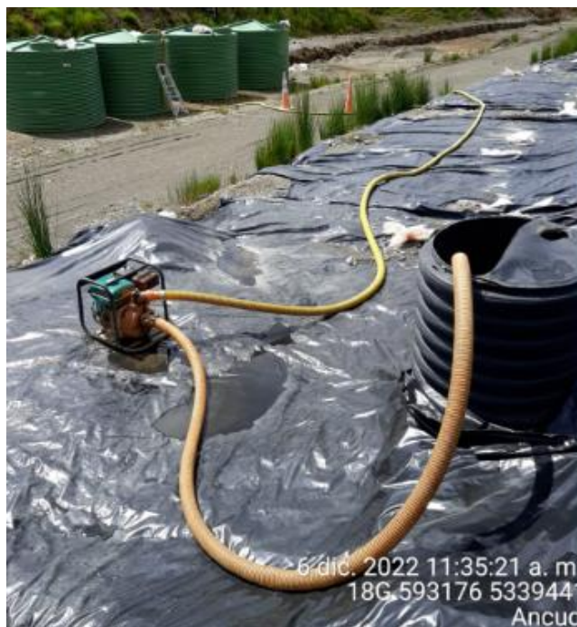
Fotografía N°3: Extracción de Lixiviados desde cámara C12 por personal municipal. Tomada: Martes 06 de Diciembre del 2022.
