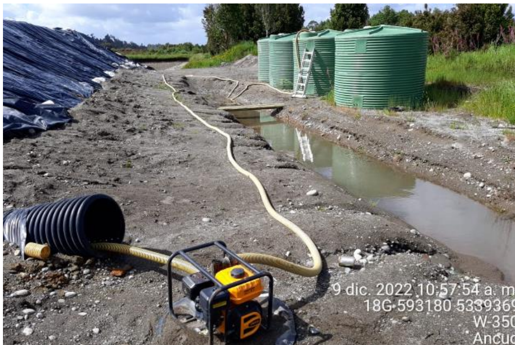
Fotografía N°10: Extracción de Lixiviados desde diagonal D02. Tomada: Viernes 09 de Diciembre del 2022.
