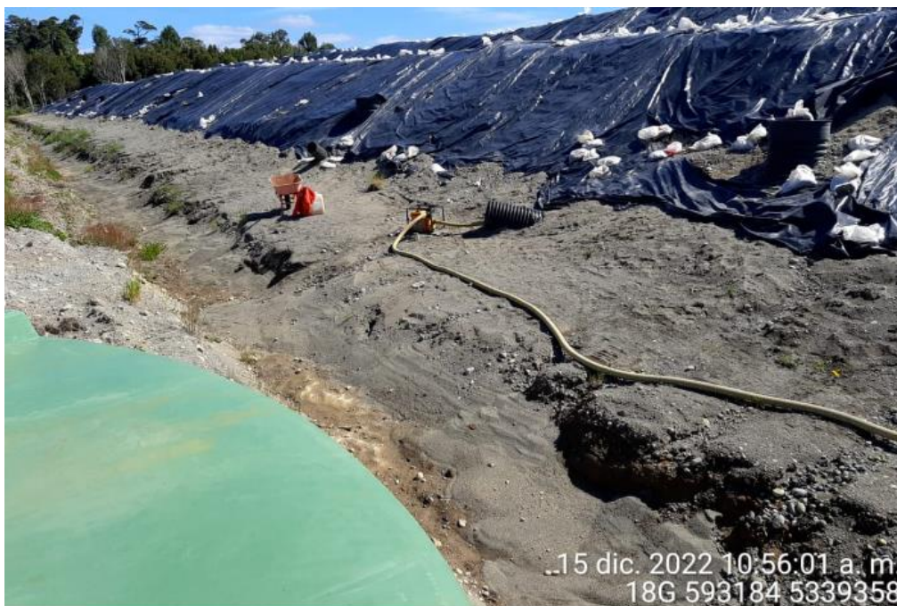
Fotografía N°36: Extracción de Lixiviados desde diagonal D02 por personal municipal. Tomada: Jueves 15 de diciembre del 2022.
