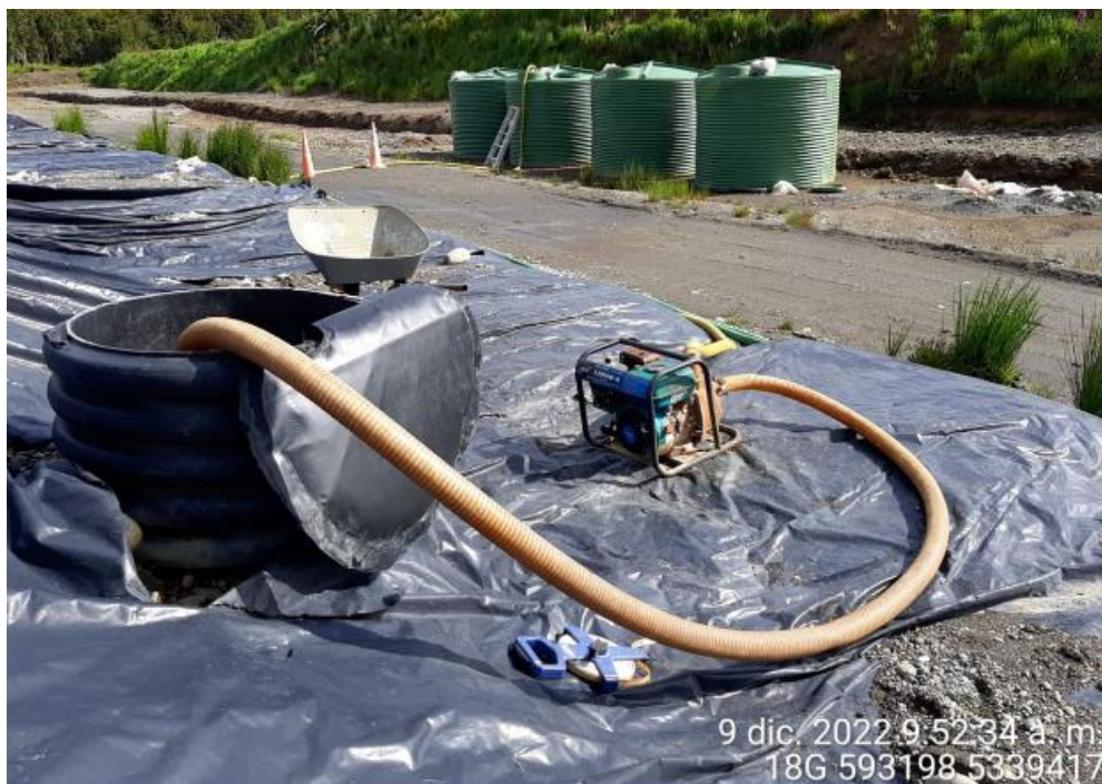
Fotografía N°15: Extracción de Lixiviados desde cámara C13 por personal municipal. Tomada: Viernes 09 de Diciembre del 2022.
