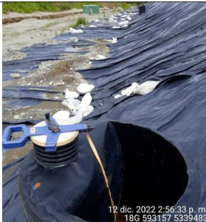
Fotografía N°51: Medición de Niveles de cámaras por Personal Municipal. Tomada: 12 de Diciembre del 2022.
