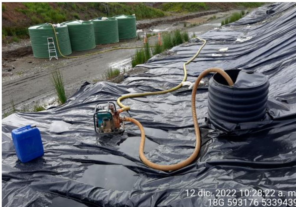
Fotografía N°17: Extracción de Lixiviados desde cámara C12 por personal municipal. Tomada: Lunes 12 de Diciembre del 2022.
