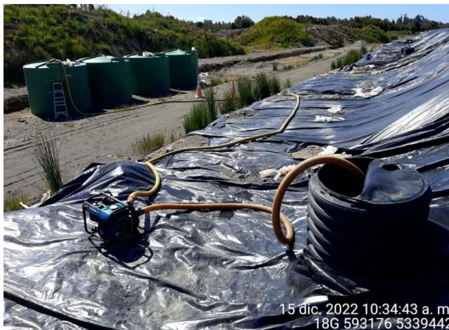
Fotografía N°38: Extracción de Lixiviados desde cámara C12 por personal municipal. Tomada: Jueves 15 de diciembre del 2022.
