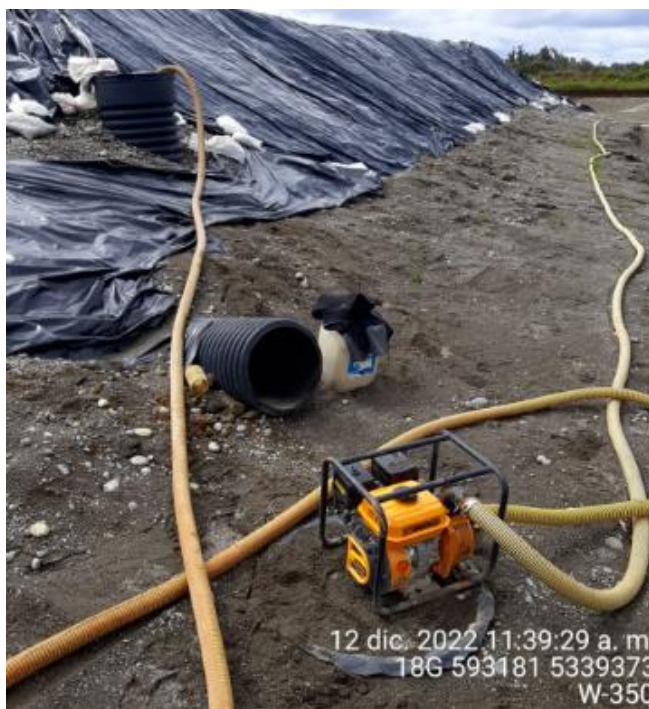
Fotografía N°21: Extracción de Lixiviados desde cámara C02. Tomada: Lunes 12 de Diciembre del 2022.
