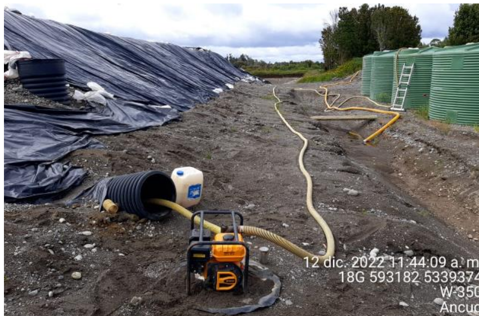
Fotografía N°20: Extracción de Lixiviados desde diagonal D02 por personal municipal. Tomada: Lunes 12 de Diciembre del 2022.
