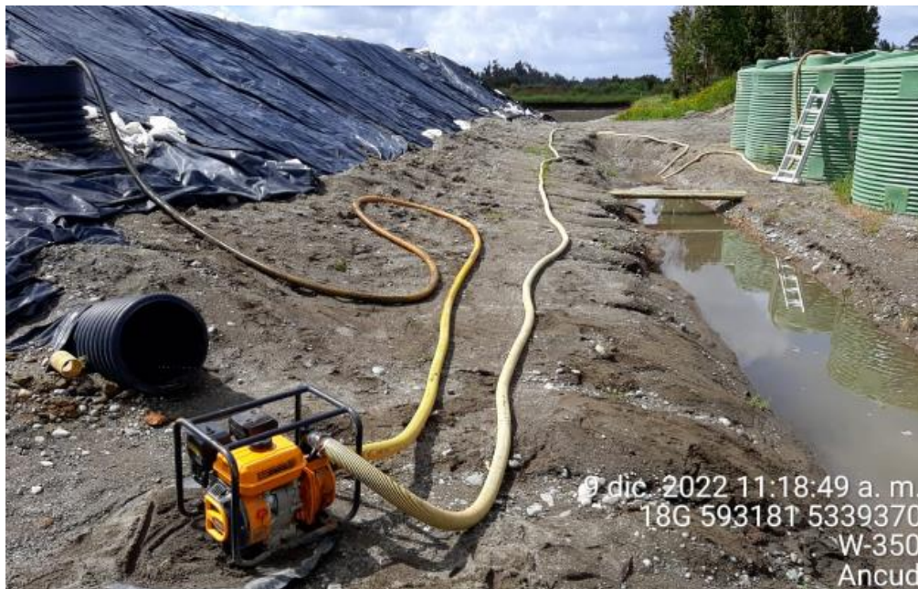
Fotografía N°11: Extracción de Lixiviados desde cámara C02. Tomada: Viernes 09 de Diciembre del 2022.
