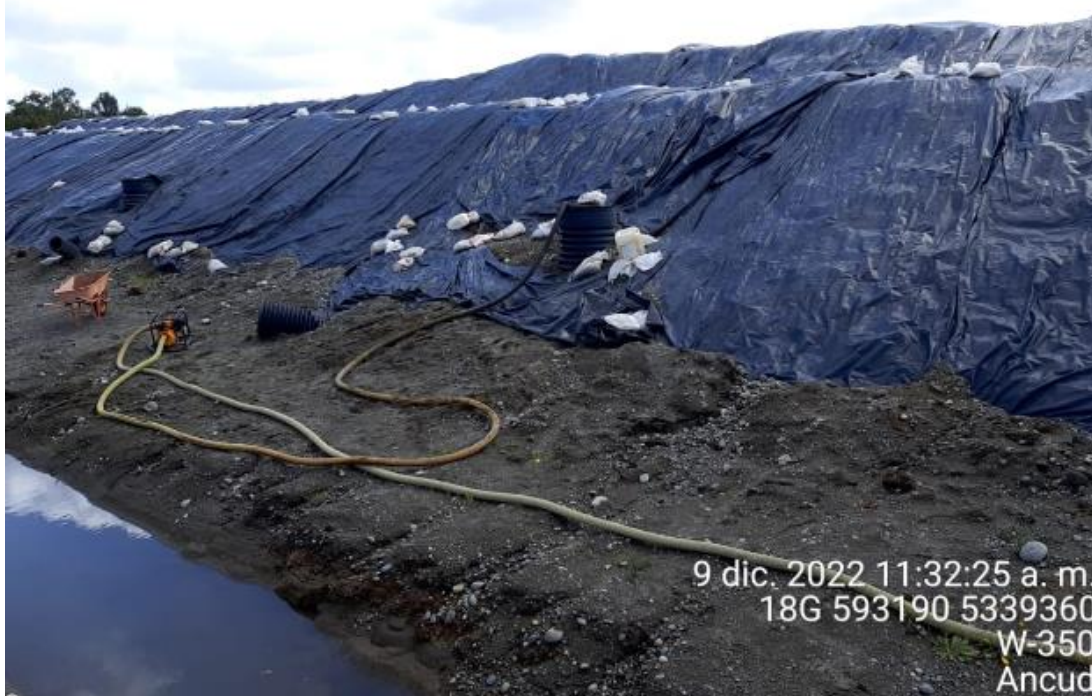
Fotografía N°12: Extracción de Lixiviados desde cámara C03. Tomada: Viernes 09 de Diciembre del 2022.
