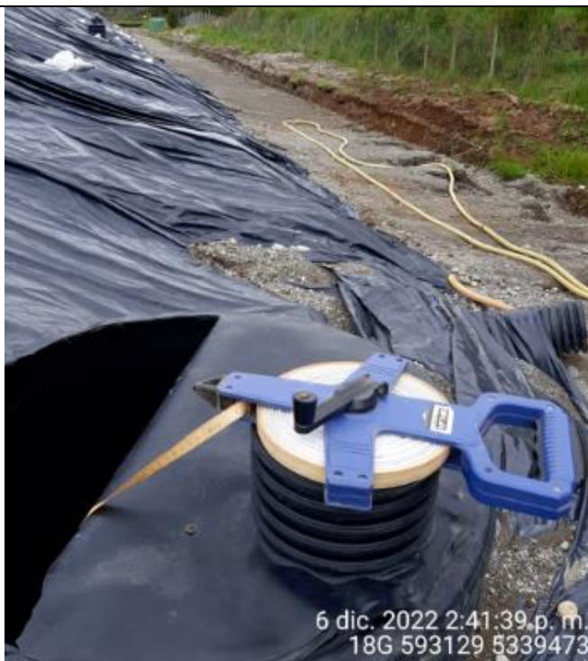
Fotografía N°48: Medición de Niveles de cámaras por Personal Municipal. Tomada: 06 de Diciembre del 2022.
