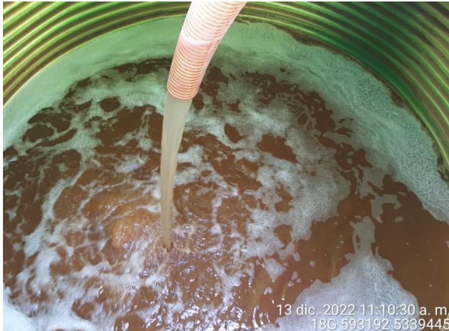
Fotografía N°29: Extracción de Lixiviados a estanque. Tomada: Martes 13 de Diciembre del 2022.
