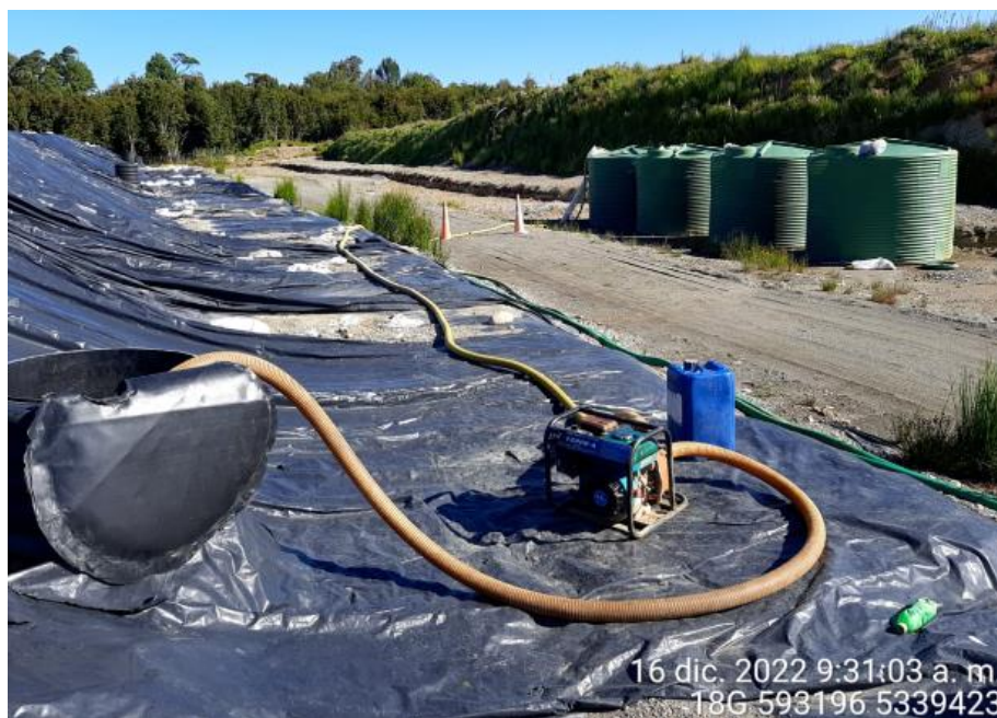
Fotografía N°42: Extracción de Lixiviados desde cámara C13 por personal municipal. Tomada: Viernes 16 de diciembre del 2022.
