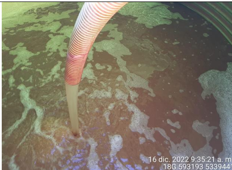
Fotografía N°43: Extracción de Lixiviados a estanque. Tomada: Viernes 16 de diciembre del 2022.
