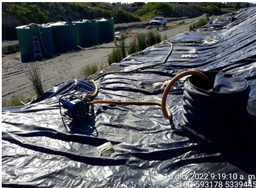
Fotografía N°41: Extracción de Lixiviados desde cámara C12 por personal municipal. Tomada: Viernes 16 de diciembre del 2022.
