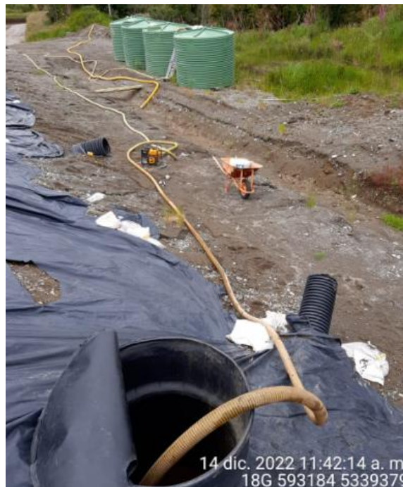
Fotografía N°30: Extracción de Lixiviados desde cámara C03 por personal municipal. Tomada: Miércoles 14 de Diciembre del 2022.
