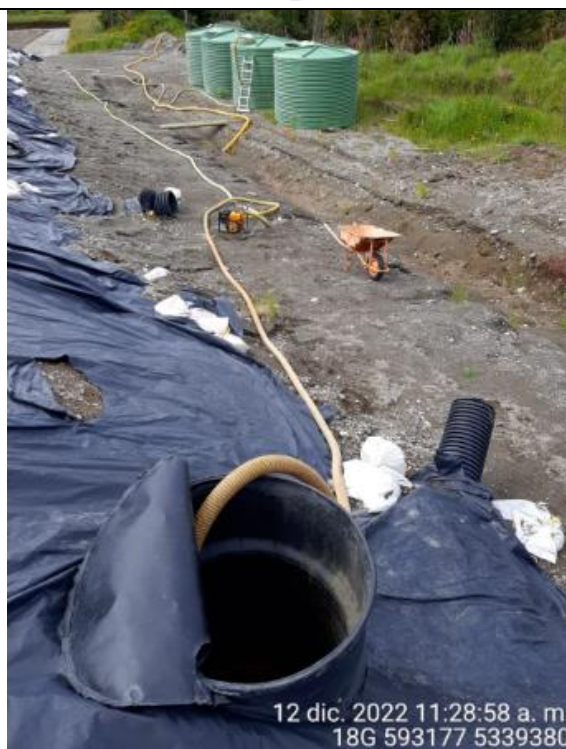
Fotografía N°22: Extracción de Lixiviados desde cámara C03. Tomada: Lunes 12 de Diciembre del 2022.
