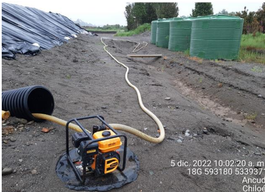
Fotografía N°1: Extracción de Lixiviados desde ducto diagonal D02. Tomada: Lunes 05 de Diciembre del 2022.
