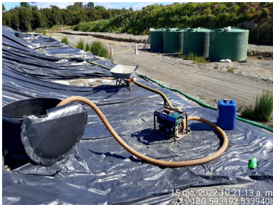
Fotografía N°39: Extracción de Lixiviados desde cámara C13 por personal municipal. Tomada: Jueves 15 de diciembre del 2022.
