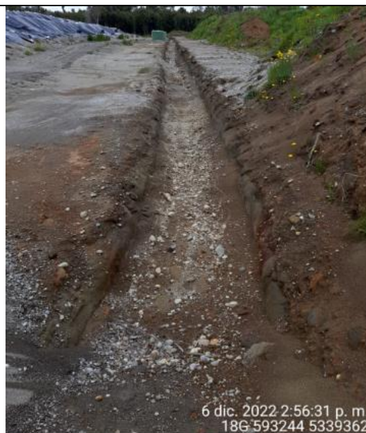
Fotografía N°58: Estado canales aguas lluvias
