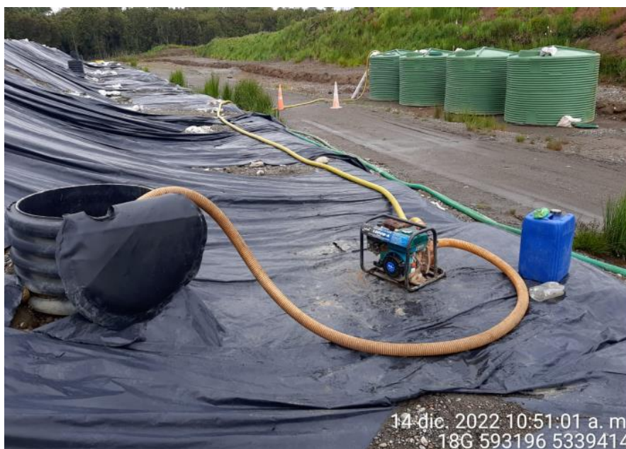
Fotografía N°34: Extracción de Lixiviados desde cámara C13 por personal municipal. Tomada: Miércoles 14 de Diciembre del 2022.
