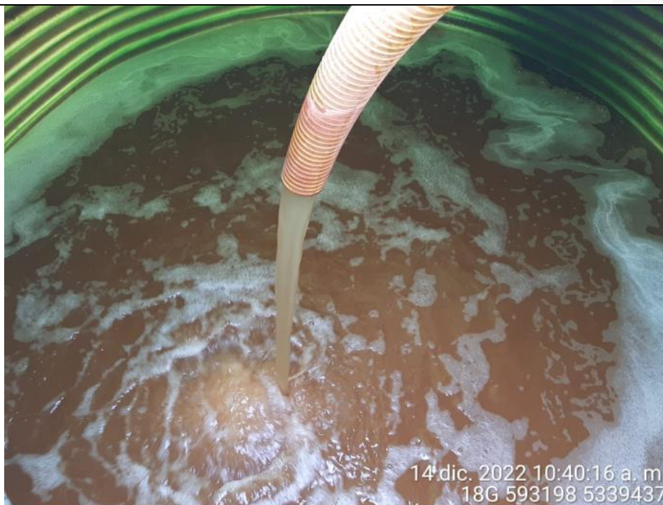
Fotografía N°35: Extracción de Lixiviados a estanque. Tomada: Miércoles 14 de Diciembre del 2022.
