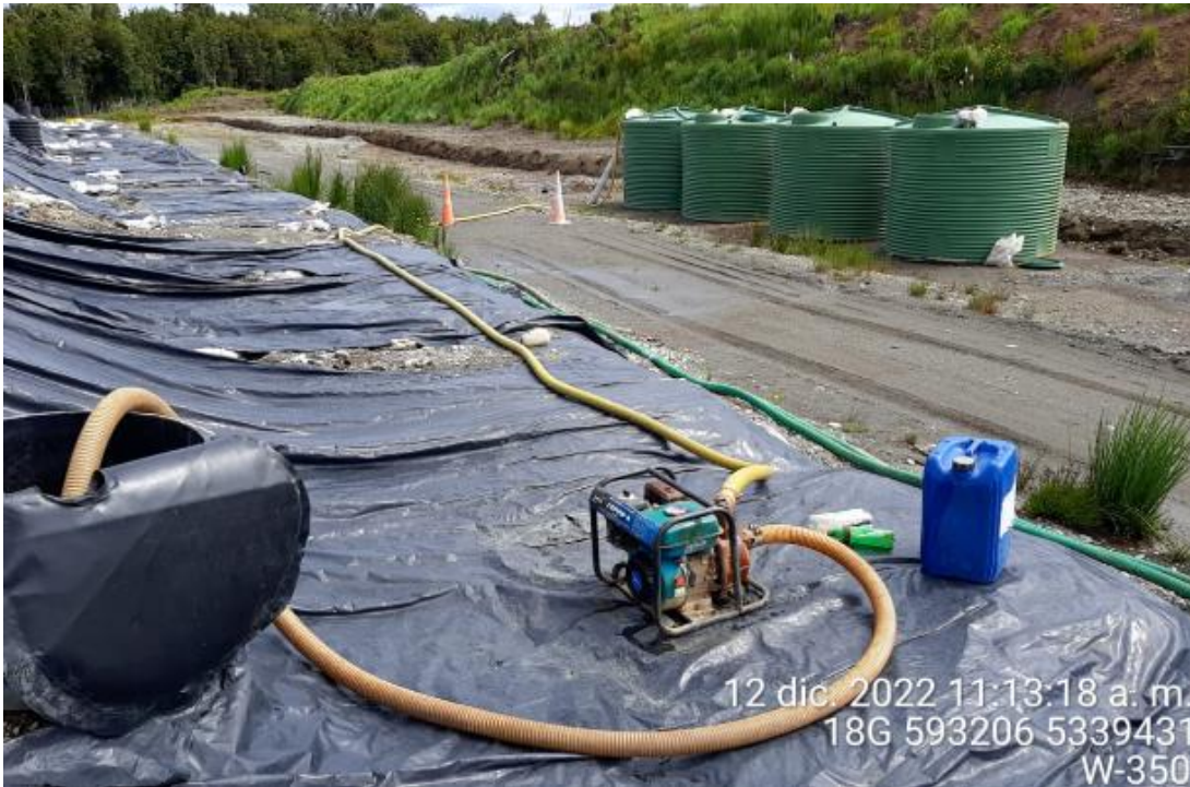
Fotografía N°18: Extracción de Lixiviados desde cámara C13 por personal municipal. Tomada: Lunes 12 de Diciembre del 2022.
