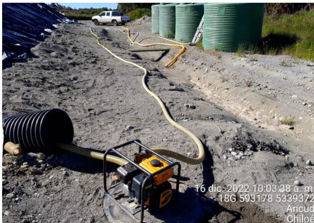
Fotografía N°44: Extracción de Lixiviados desde diagonal D02 por personal municipal. Tomada: Viernes 16 de diciembre del 2022.
