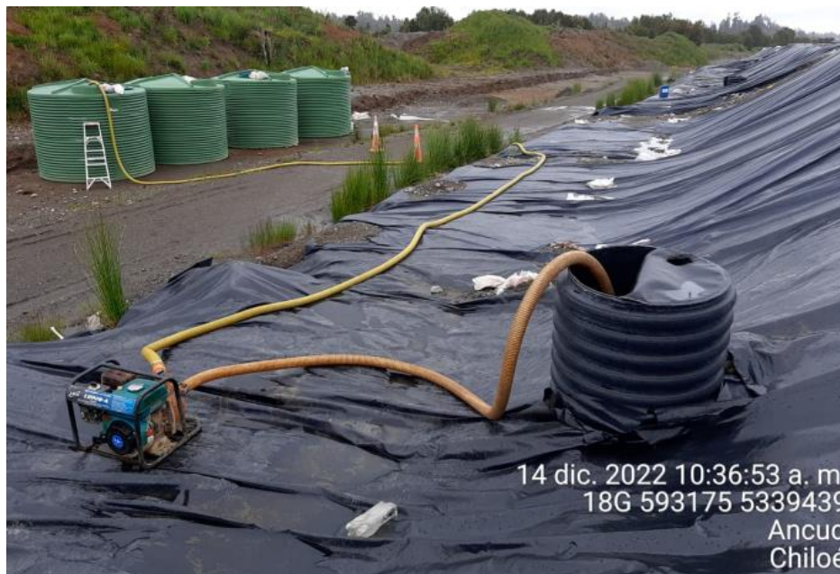
Fotografía N°33: Extracción de Lixiviados desde cámara C12 por personal municipal. Tomada: Miércoles 14 de Diciembre del 2022.
