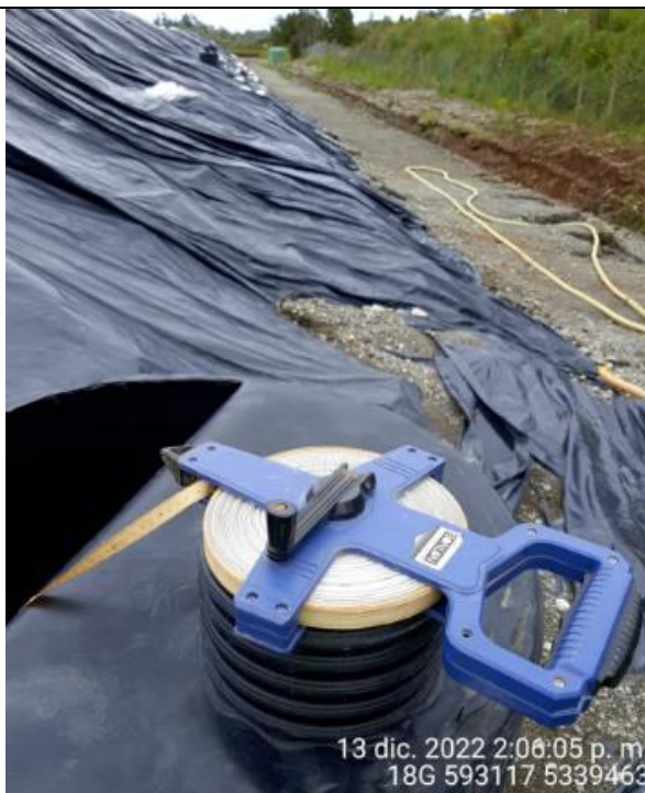
Fotografía N°52: Medición de Niveles de cámaras por Personal Municipal. Tomada: 13 de Diciembre del 2022.
