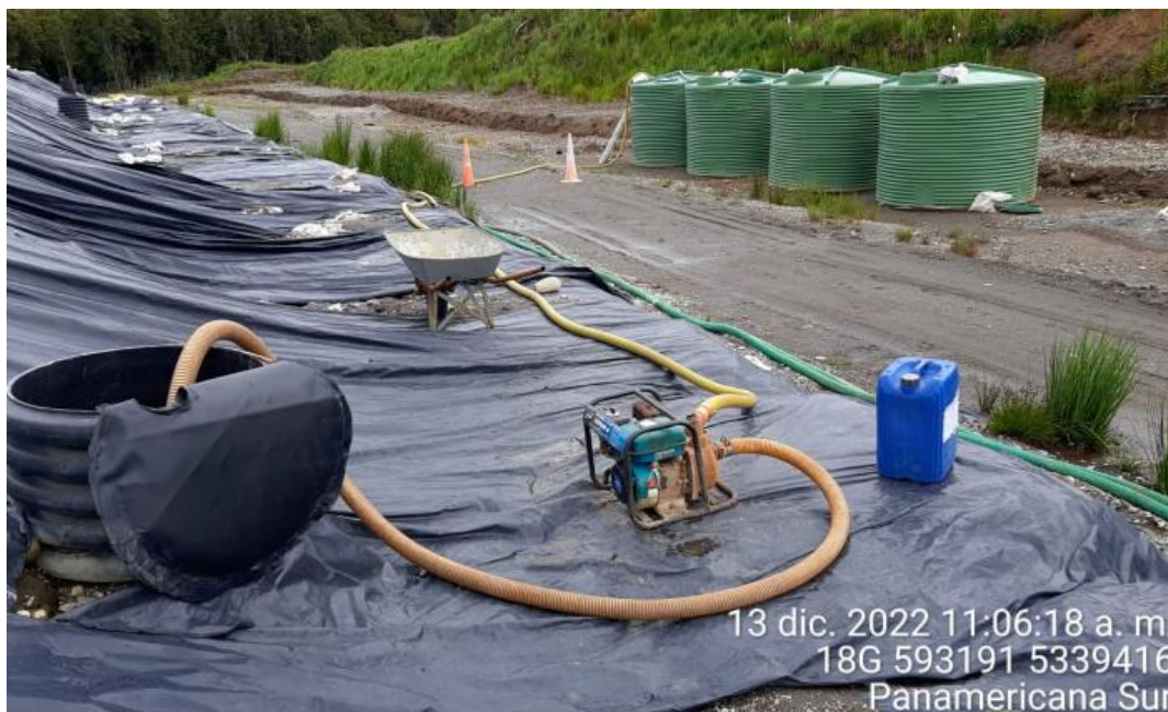
Fotografía N°28: Extracción de Lixiviados desde cámara C13 por personal municipal. Tomada: Martes 13 de Diciembre del 2022.
